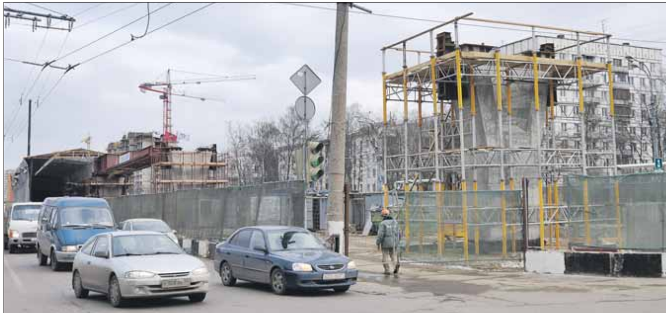
Новый метод строительства позволяет не перекрывать движение под эстакадой
