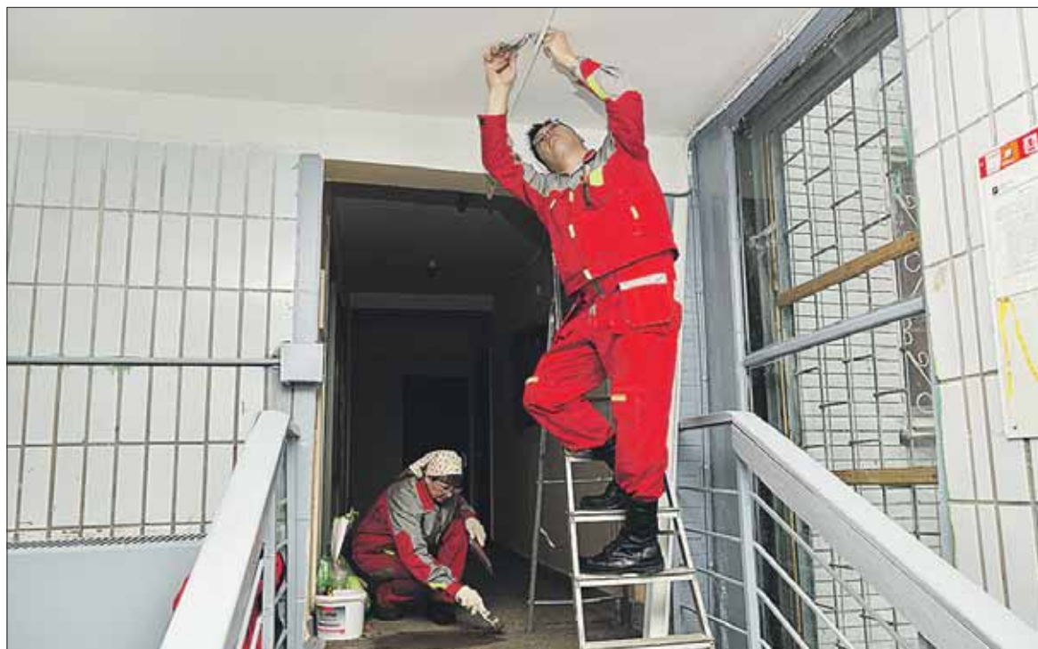
Маляры приступили к ремонту подъездов в округе
