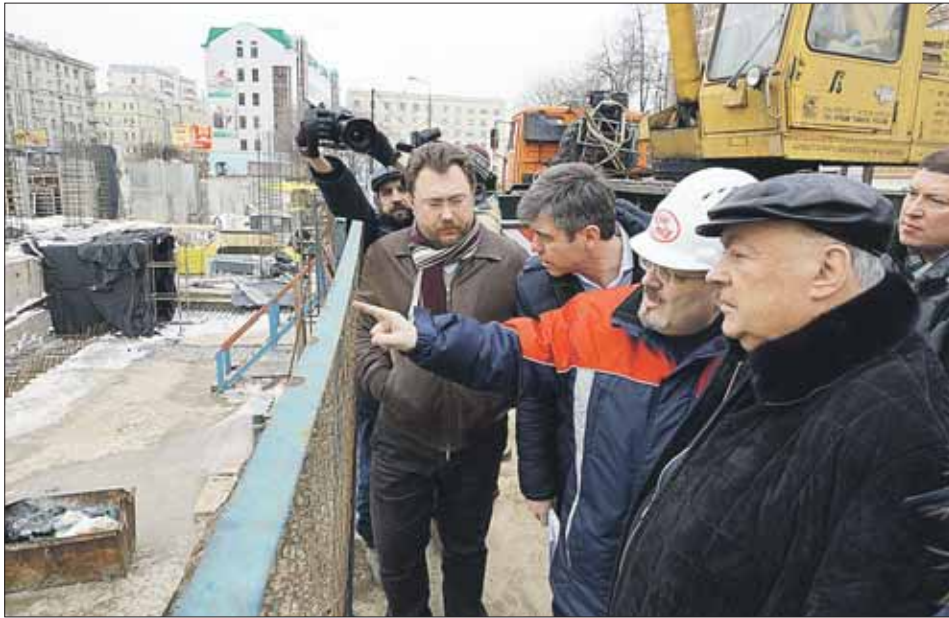
Владимир Ресин осматривает стройплощадку Преображенского храма
