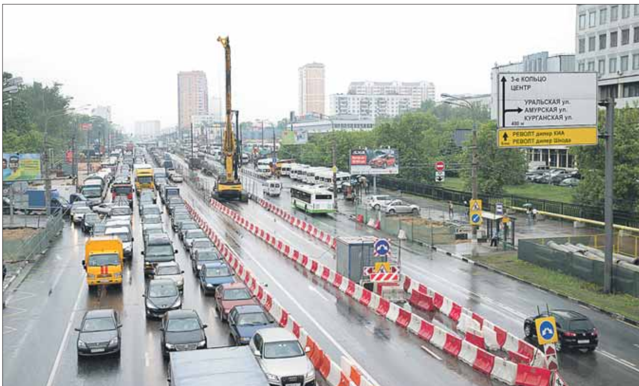
Реконструкция шоссе в полном разгаре
