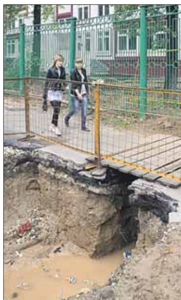
Траншею на Измайловском бульваре обещают засыпать в III квартале
