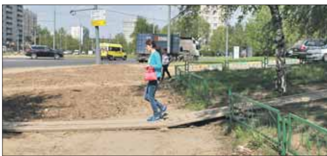
Перекладка коммуникаций на перекрёстке сильно затянулась
