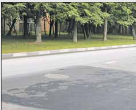
жей части в месте прокладки подземных коммуникаций на улице Монтажной устранено».
