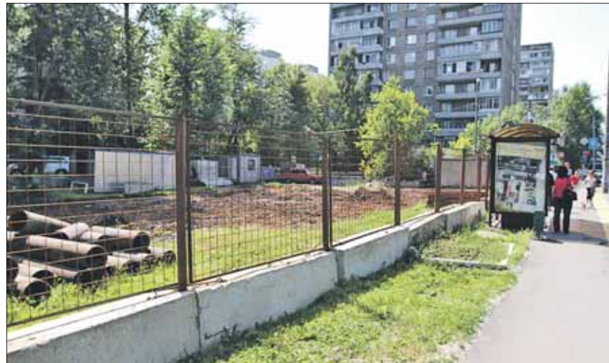
На месте стройки будет зелёная зона с полноценной детской площадкой
