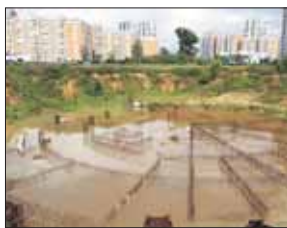
Котлован скоро закопают
