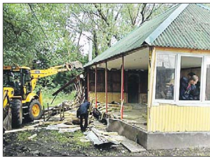
Снос незаконно возведённого строения в парке
