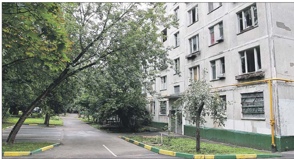
Дом на Халтуринской уже отселён и готов к сносу
