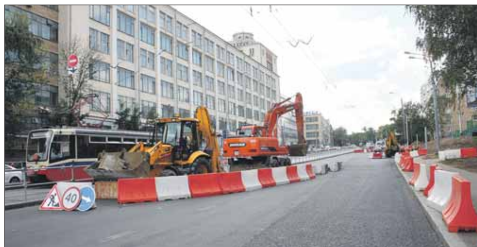
Работы по расширению улицы Стромьинки у домов 15-17 завершаются
