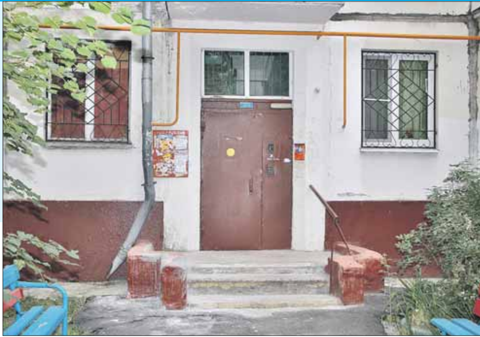
Инженерные коммуникации в этом доме не менялись с 1966 года
