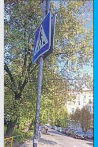
Неправильно развёрнут дорожный знак на пересечении 2-го Полевого переулка и Большой Остроумовской улицы
