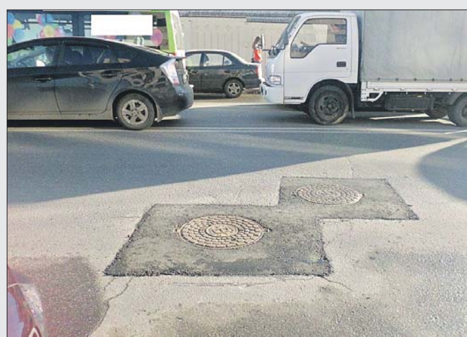
Очередные заплатки вокруг канализационных люков на Электродной
