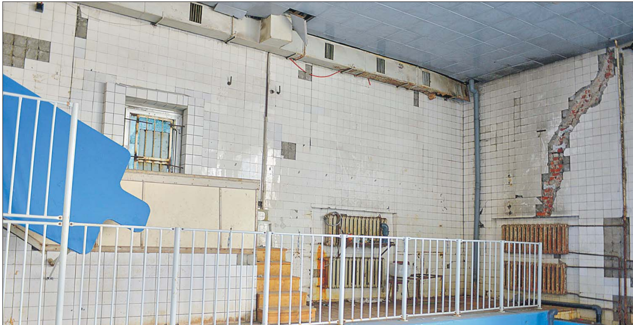
Стена «поползла», потому что солёная вода разъела конструкции бассейнов
