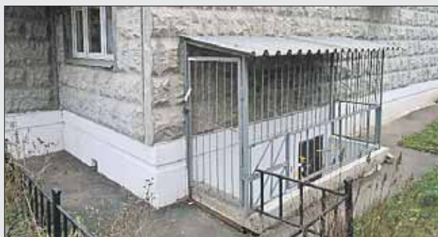
Подвал на 15-й Парковой, 47, корпус 1
