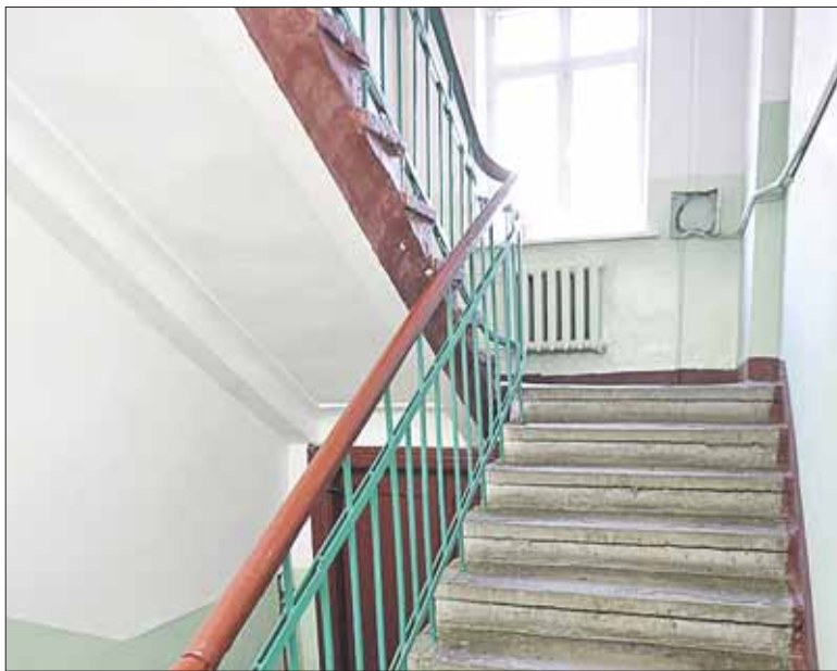
Отремонтированный подъезд на улице Первомайской, 25
