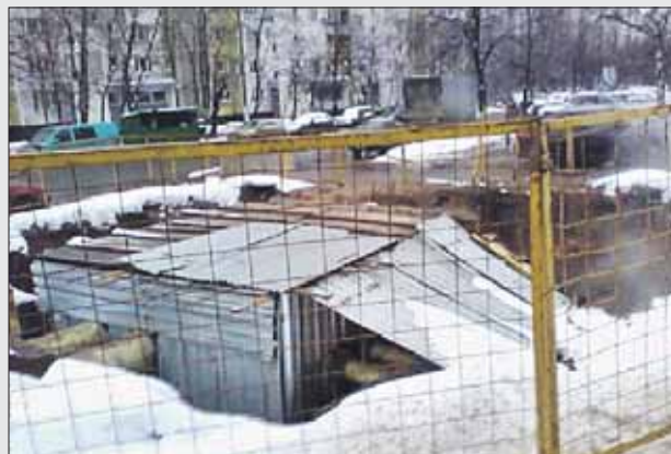
Вот такое сооружение зимует в траншее на Челябинской, 24, корпус 1, с прошлой осени
