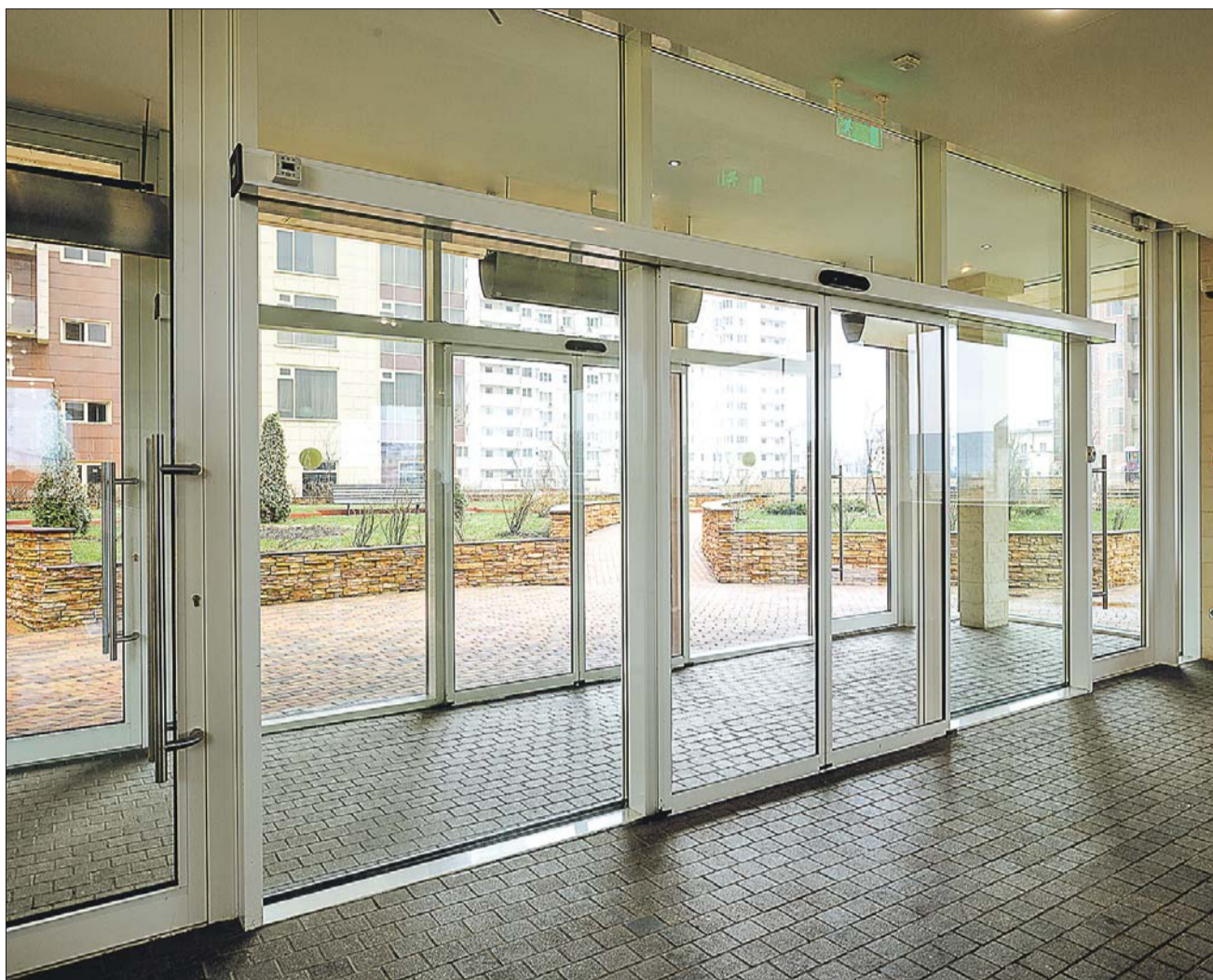
Подъезды оснащаются низкими порогами. Керамическая плитка на полу холлов обеспечивает чистоту подъездов
