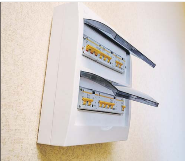
Все квартиры оснащены индивидуальными приборами учёта воды и электроэнергии, показания которых будут передаваться автоматически
