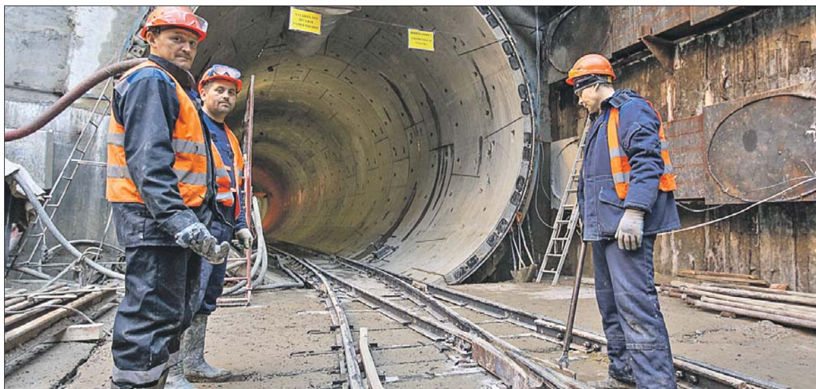
Идёт прокладка тоннеля на Кожуховской линии
