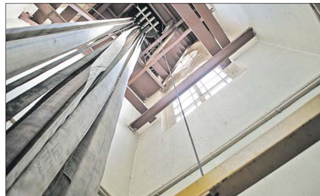
Пожарные рукава сушатся внутри каланчи
