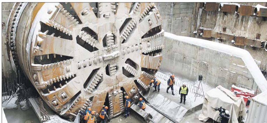
Тоннелепроходческий щит работает на Кожуховской ветке метро
