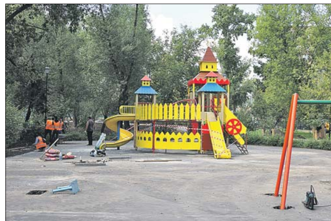
Идёт монтаж детской площадки
