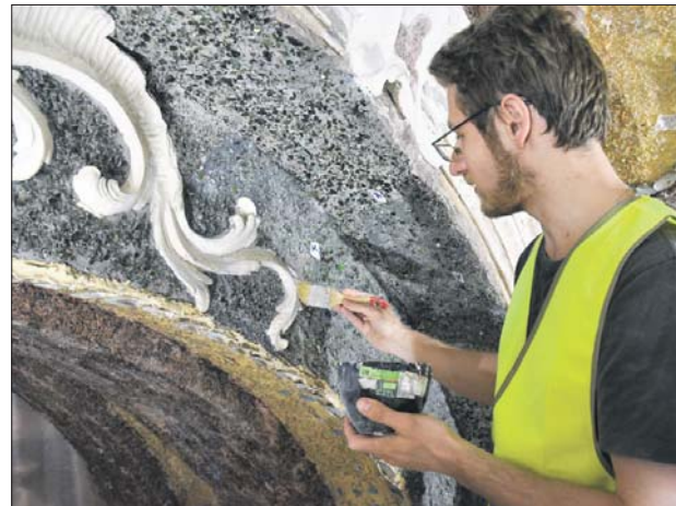
Идёт реставрация каменных сводов грота
