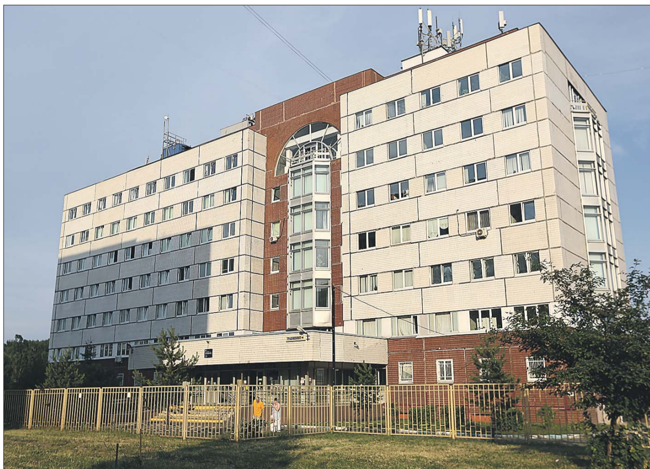
Новая поликлиника в районе оборудована современной диагностической аппаратурой
