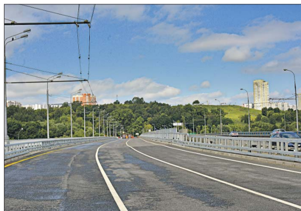
Крылатский мост станет частью Северо-Западной хорды
