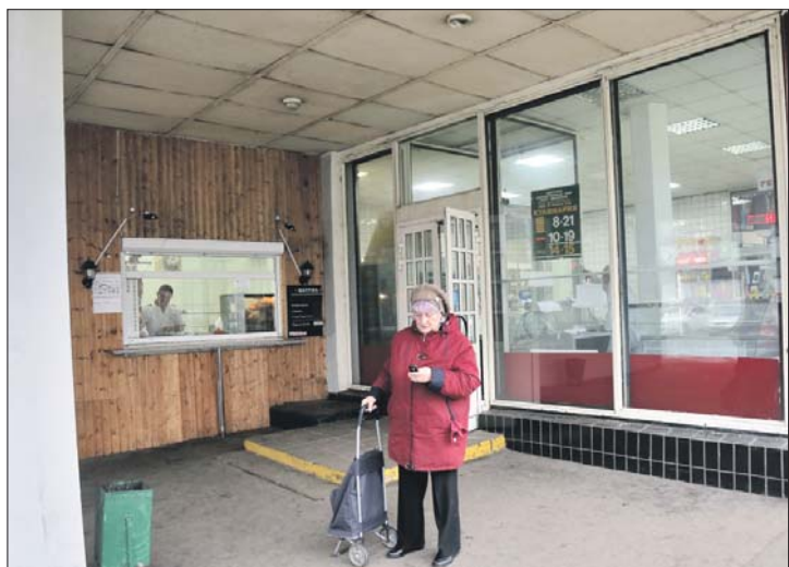
Конструкцию на фасаде кафе демонтировали
