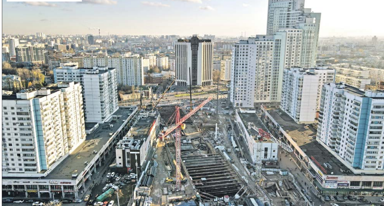
Идёт строительство станции БКЛ «Сокольники»
