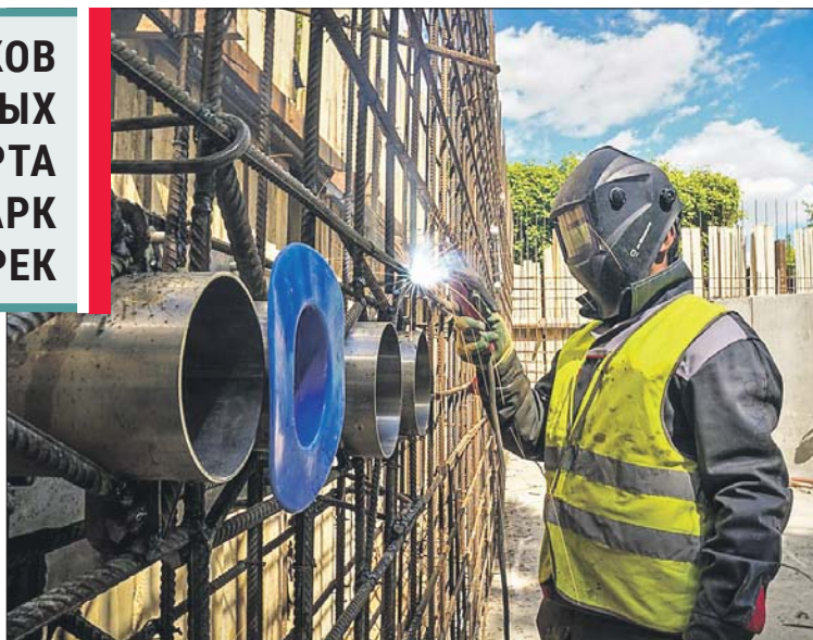
К фонтану подводят коммуникации
