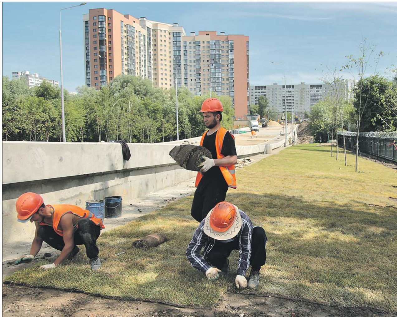
Участки земли вокруг моста застелют рулонным газоном
