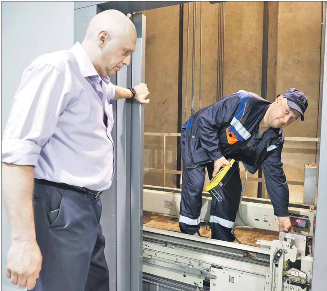
Ремонт лифта в доме на Погонном проезде
