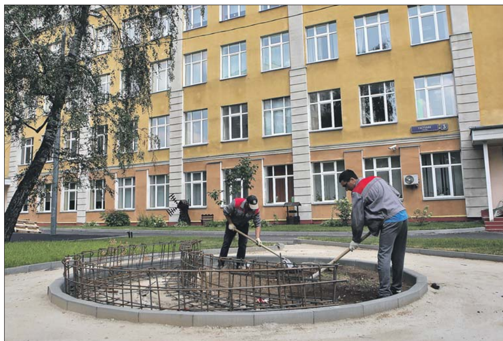
Работы у школы №1530 на улице Гастелло
