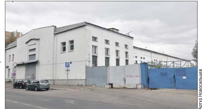
Промзона на Перовом поле, где предположительно располагалось шёлковое производство Рошфора
