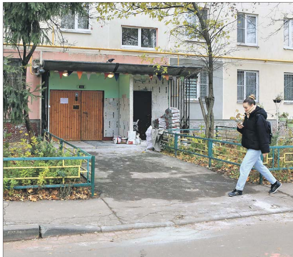
Брошенный строителями дом на шоссе Энтузиастов, 100, корпус 7, готовят к зиме
