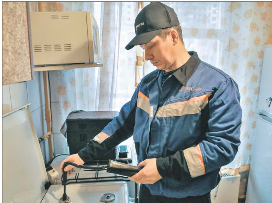
Владислав Мефед проверяет плиту в доме на Утренней, 7
