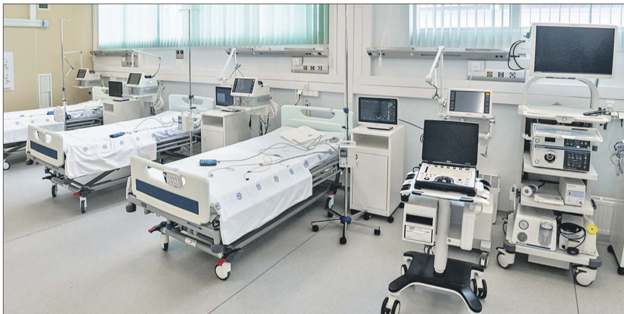
Госпиталь оснащён современным оборудованием, в том числе аппаратами КТ
