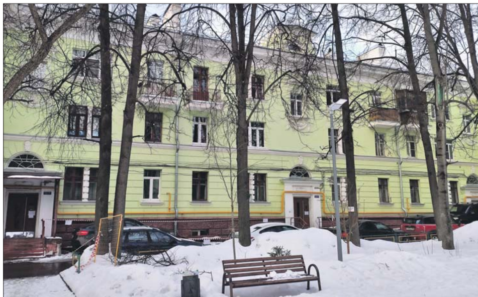
Жилой дом на 2-й Парковой, 18
