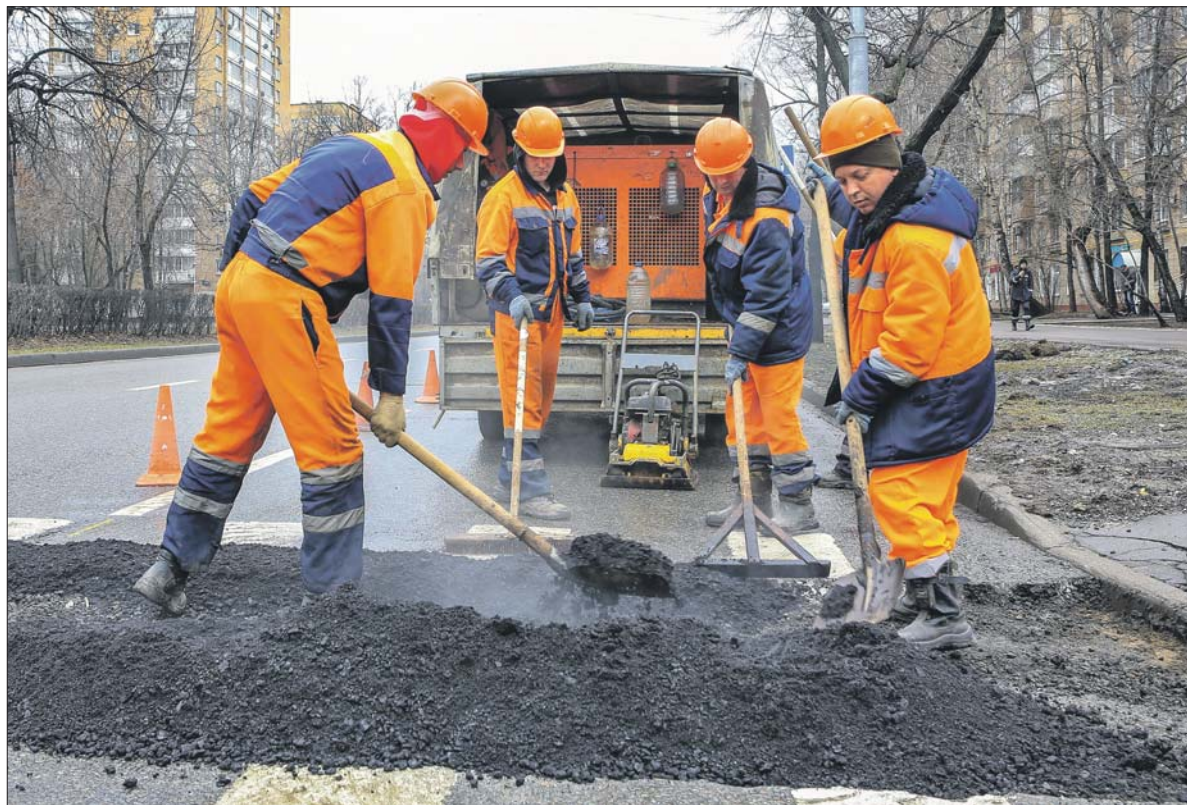
На Свободном проспекте идут дорожные работы
