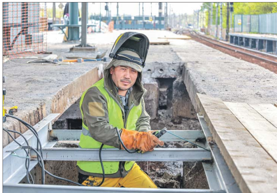
Монтаж металлических конструкций
