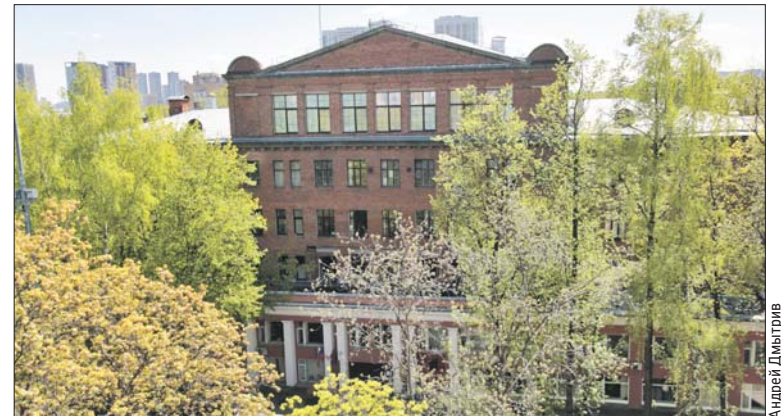
Здание бывшего Института прикладной геофизики на Глебовской
