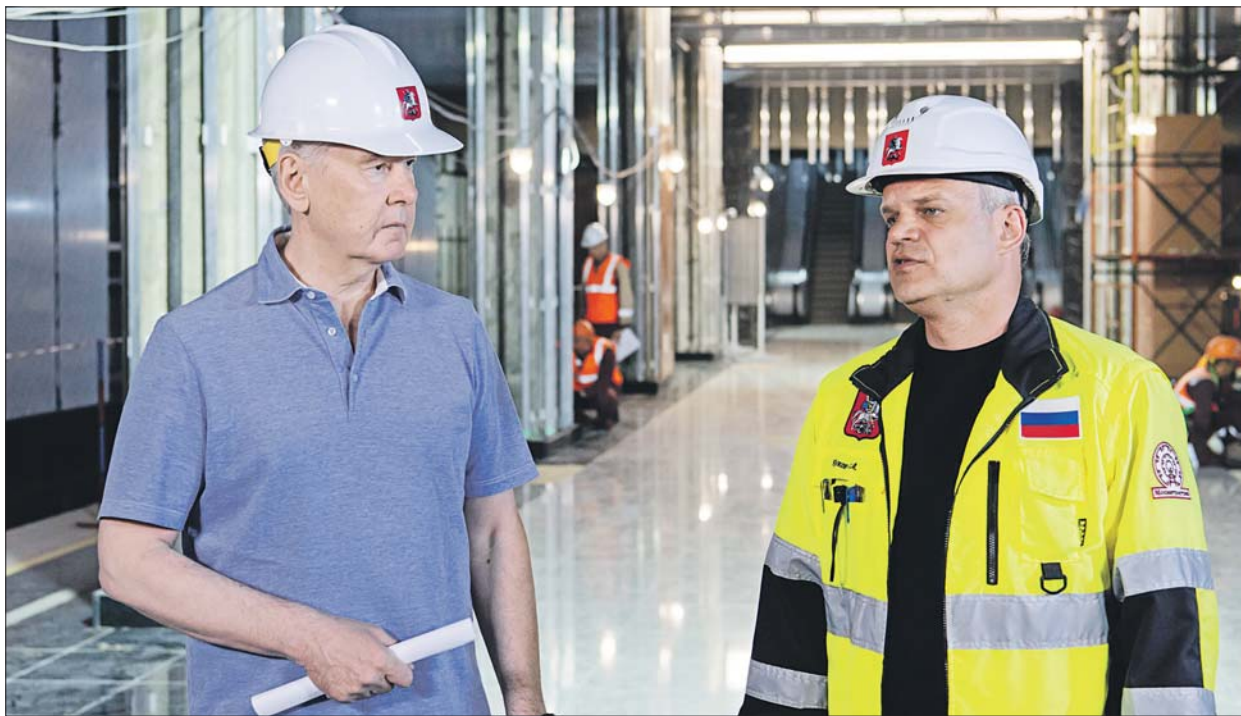
Сергей Собянин осматривает строящуюся станцию «Лианозово». Справа на фото генеральный директор Мосметростроя Сергей Жуков
