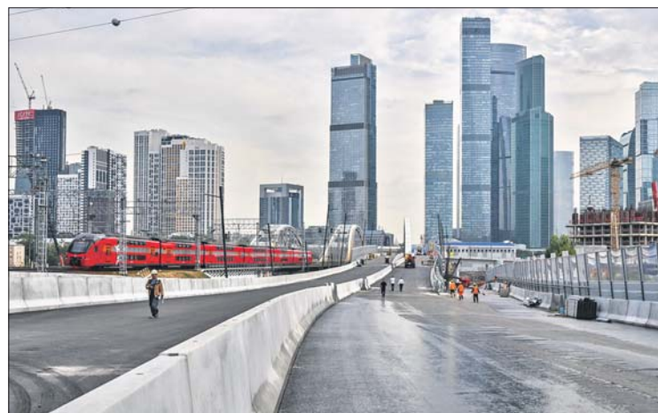
На трассе расположили две эстакады основного хода
