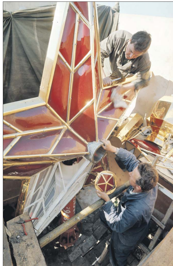
Ремонт кремлёвской звезды, 1970-е годы
