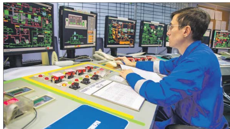
Профилактические работы проведены на всех ТЭЦ
