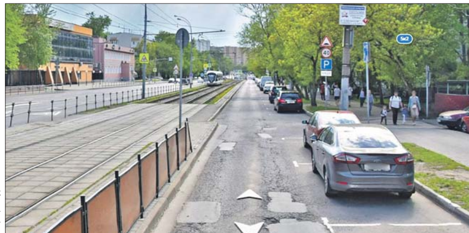
Обустройство нового перехода на Открытом шоссе, 5, корпус 1: так было...
