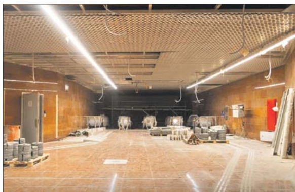
Строительство пересадки между станцией «Электрозаводская» БКЛ и Арбатско-Покровской линией
